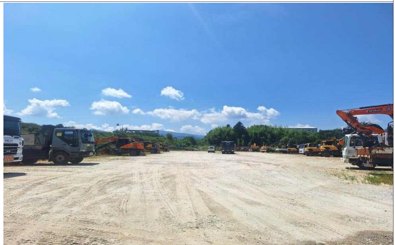
현장사진 : 거창군 거창읍 정장리 394번지 일원
